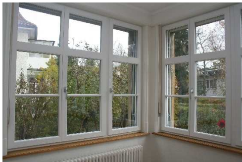
Fensterfront nach der Sanierung -Heimatschutz/Denkmalpflege
