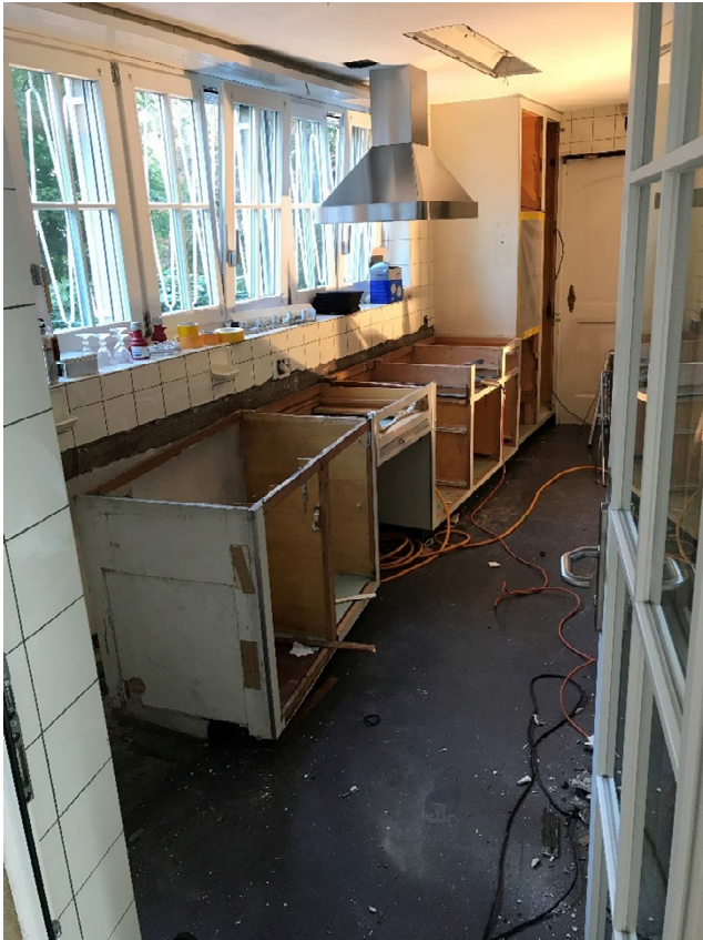
Küche während Umbauphase
